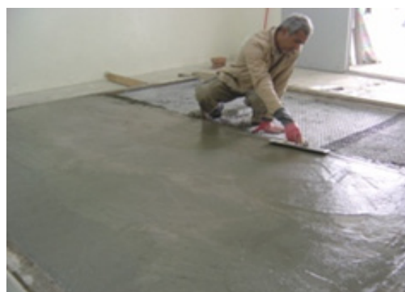
شکل ۷: مراحل اجرای کف شناور با استفاده از پلی استایرن به ضخامت ۲/۵ سانتیمتر و چگالی حجمی ۱۵ کیلوگرم بر مترمکعب در آزمایشگاه
