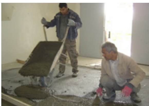
شکل ۷: مراحل اجرای کف شناور با استفاده از پلی استایرن به ضخامت ۲/۵ سانتیمتر و چگالی حجمی ۱۵ کیلوگرم بر مترمکعب در آزمایشگاه
